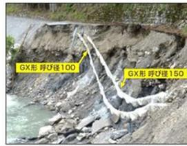
耐震継手管被災状況(被害無し)
