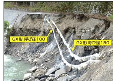
耐震継手管被災状況（被害無し）
