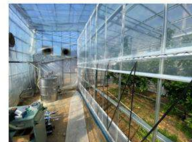
<CO2を再利用するハウス>
